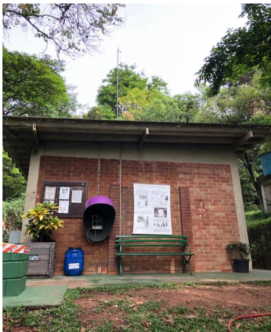
Imagem 05: SPDA no prédio administrativo
